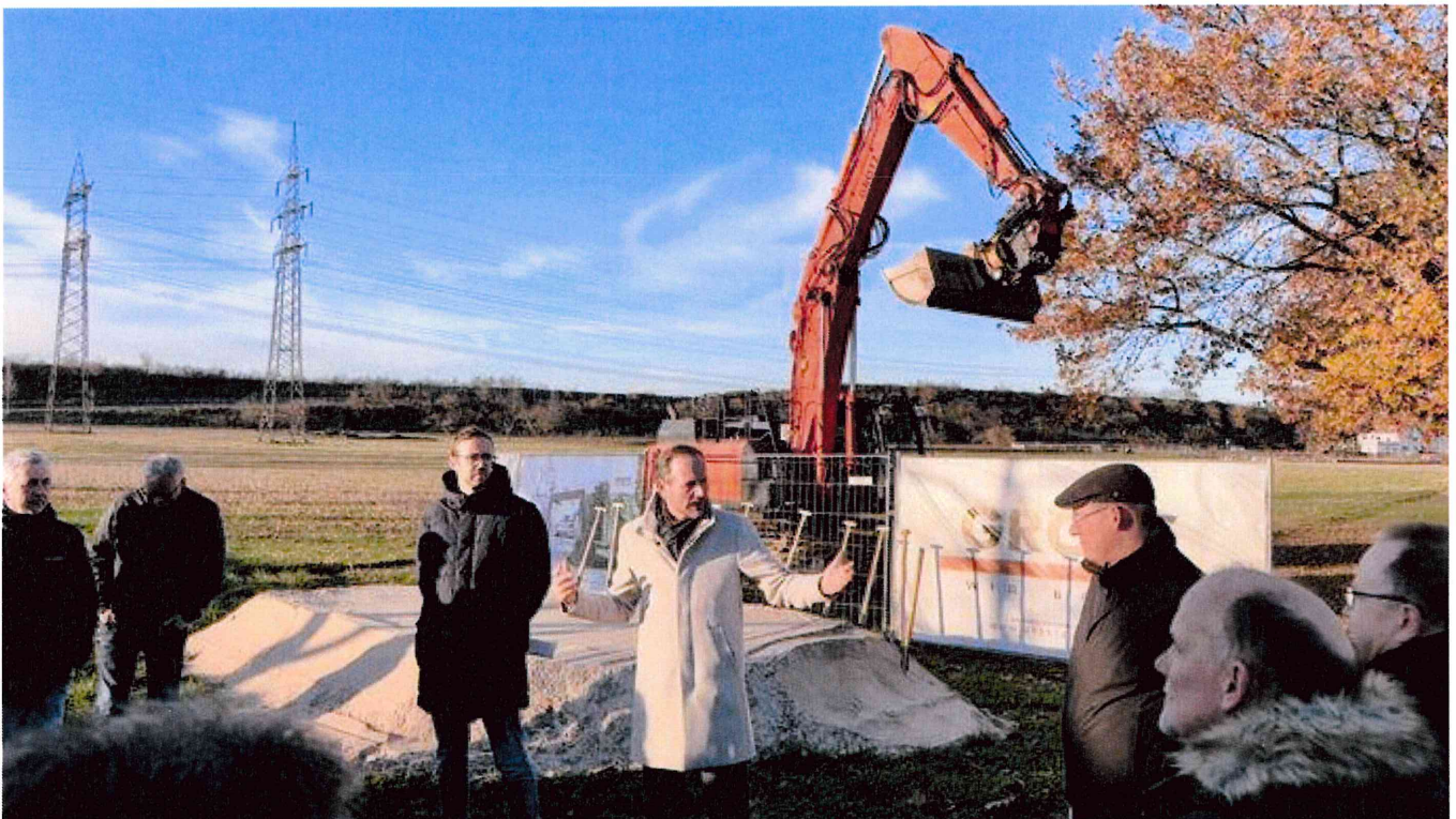
Bürgermeister Alexander Wieland freut sich, dass es nach 14 Jahren Vorbereitung und Planung nun endlich losgeht beim Baugebiet „Iffzer Weg“ in Sandweier. Foto: Harald Holzmann
